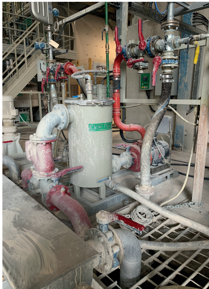
Gruppo di pompaggio per alimentazione barbottina al mulino raffinatore. Pumping group for slip feeding to the refiner mill. Grupo de bombeo para alimentación barbotina al molino refinador. Groupe de pompage pour alimentation barbotine du broyeur raffineur. Grupo de bombeo para alimentación barbotina al molino refinador.
