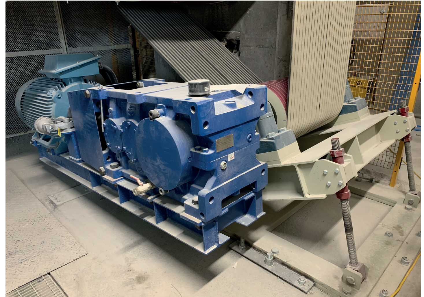
Dettaglio trasmissione su mulino continuo raffinatore. Transmission detail on continuous refiner mill. Detalle transmisión en molino refinador continuo. Détail de transmission sur broyeur raffineur continu. Detalhe da transmissão no moinho continuo refinador.
